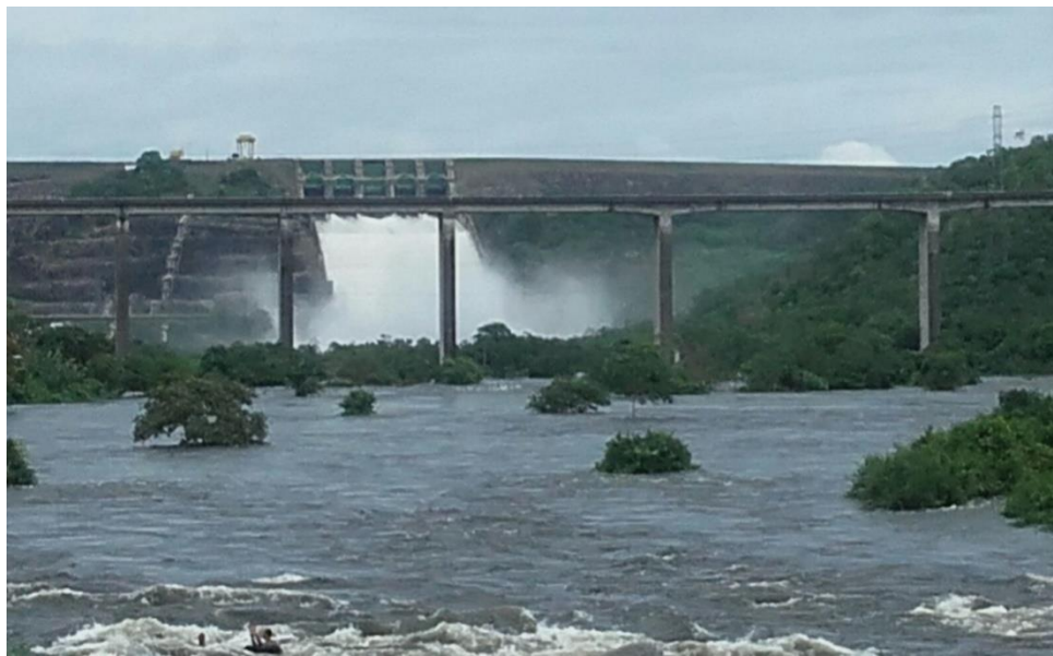
Foto 2 – Barragem de Pedra do Cavalo
