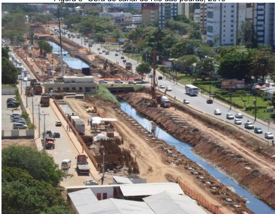
Figura 9- Obra do canal do Rio das pedras, 2010
