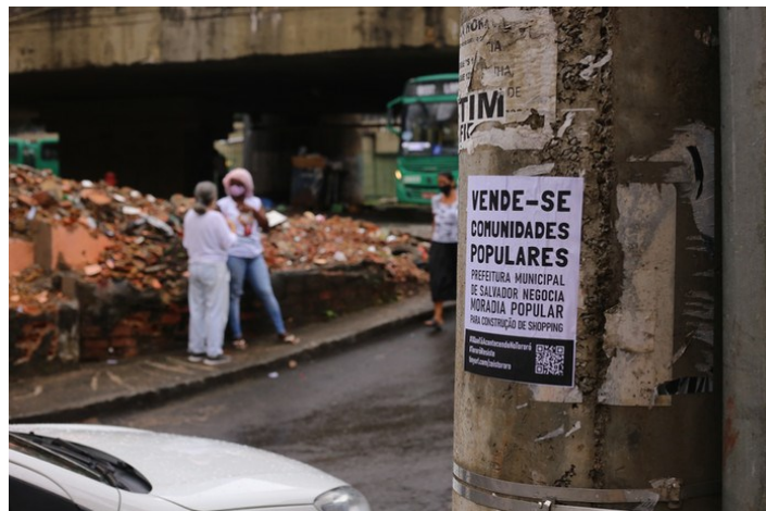
Figura 15 - Demolições no Tororó
