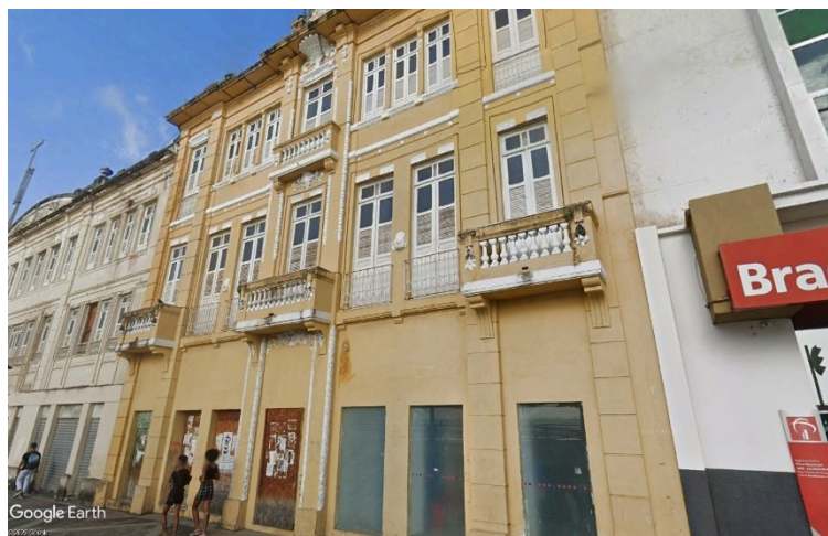
Figura 30 - Prédio dos Alfaiates CHS
