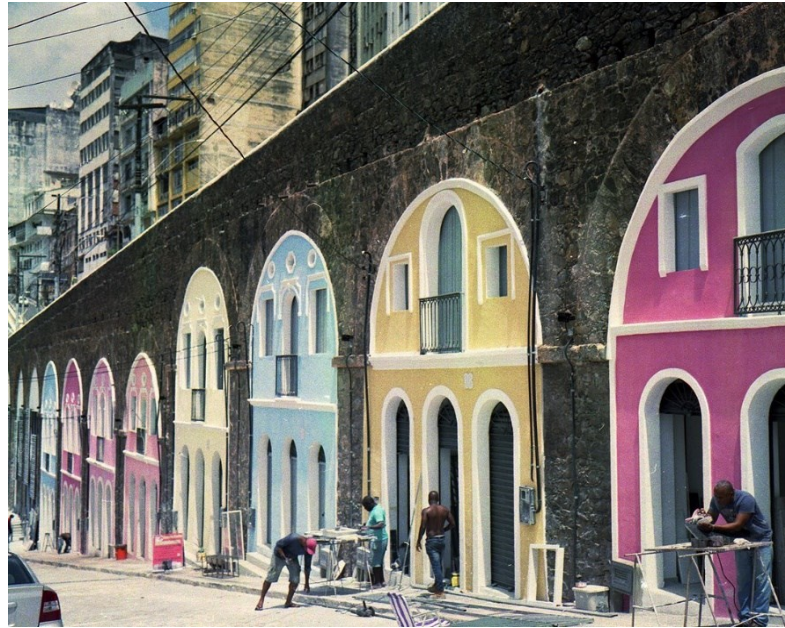
Figura 8 – Arcos da Ladeira da Conceição da Praia após reforma
