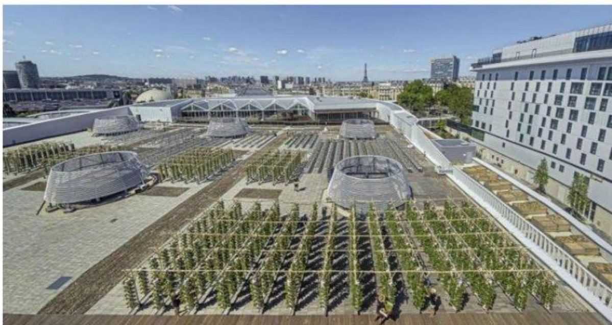
Figura 2: Horta urbana sobre telhado é inaugurada em Paris
