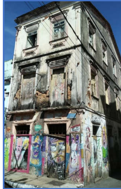
Figura 19 - Imóvel nº2 no ano de 2019. Foto do Autor. Jan. 2019
