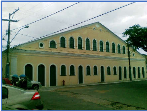
Figura 17 - Casa do Oitão Fonte: Pacto Engenharia e Consultoria
