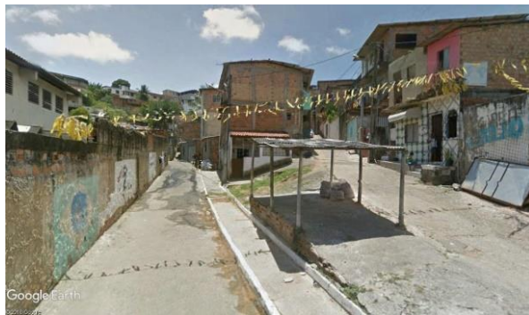
Figura 63 – Acessos irregulares nas ZEIS
