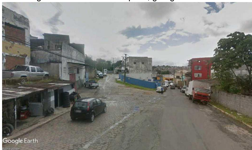
Figura 36 – Setor D – Galpões, garagens e oficinas
