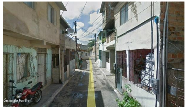
Figura 64 – Acessos irregulares nas ZEIS
