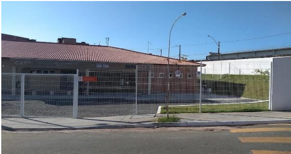
Figura 5: Fachada do CAPS III
