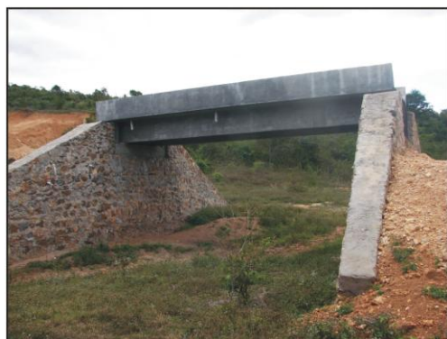
PA Europa: Ponte em construção / INCRA Foto: Paulo Coqueiro / 2007.
