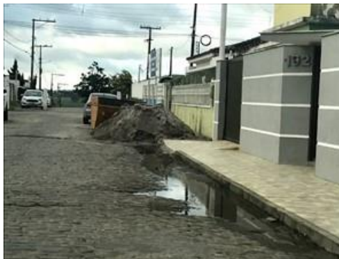
Figura 47 – Calçada na rua Isaías Alves
