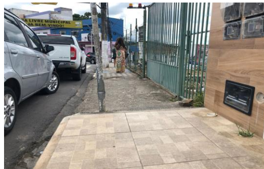
Figura 42 – Calçadas irregulares na rua Tiradentes
