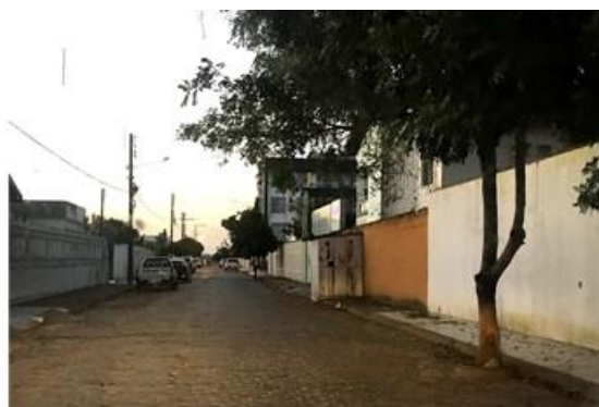
Figura 50 – Calçadas com obstáculos de construções irregulares, na rua Isaías Alves
