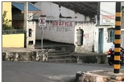
Figura 41 – Calçadas com desníveis na rua Tiradentes
