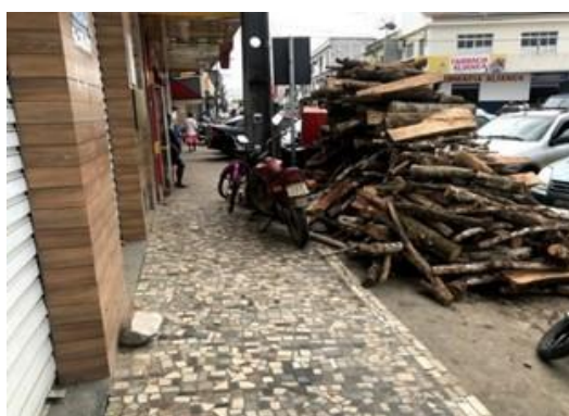
Figura 49 – Calçada com material (lenha), na rua Alan Kardec
