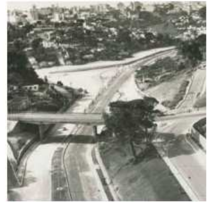
Construção da Avenida Vale do Canela. Década de 1970. Detalhe.
