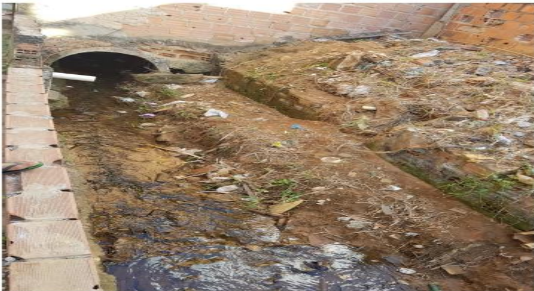
Figura 16 – Canal que chega até o local onde será construída a praça de Saramandaia
