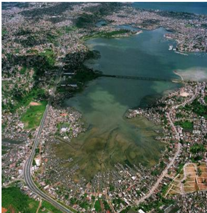
Figura 6 - Novos Alagados antes da intervenção física: 1996 Fonte: CONDER
