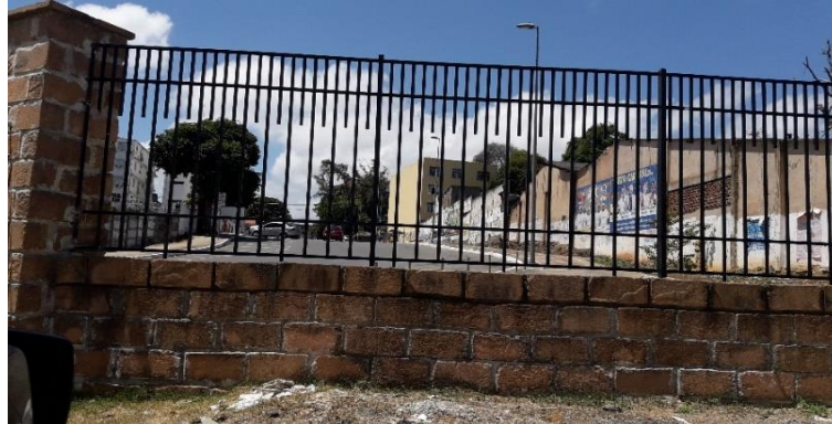
Figura 78 Muro dividindo o Horto Bela Vista do bairro de Pernambués
