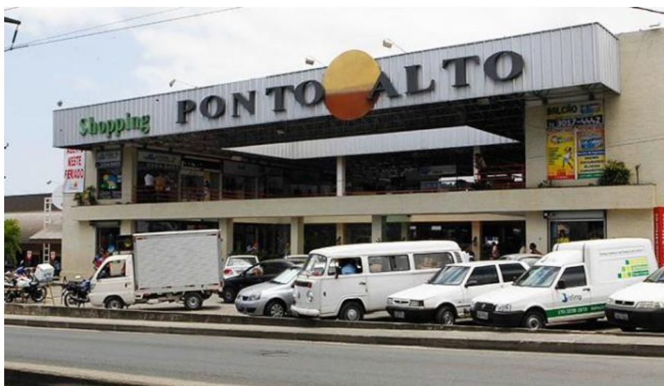
Figura 39 - Shopping Ponto Alto - fachada
