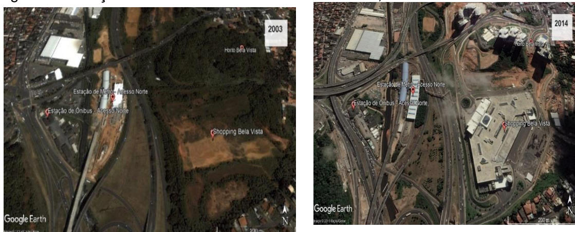
Figura 65 Estação Acesso Norte do Metrô - Salvador, 2003 e 2014
