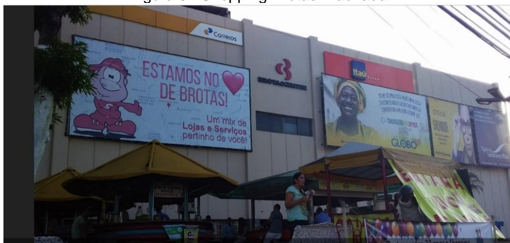
Figura 37 Shopping Brotas - fachada
