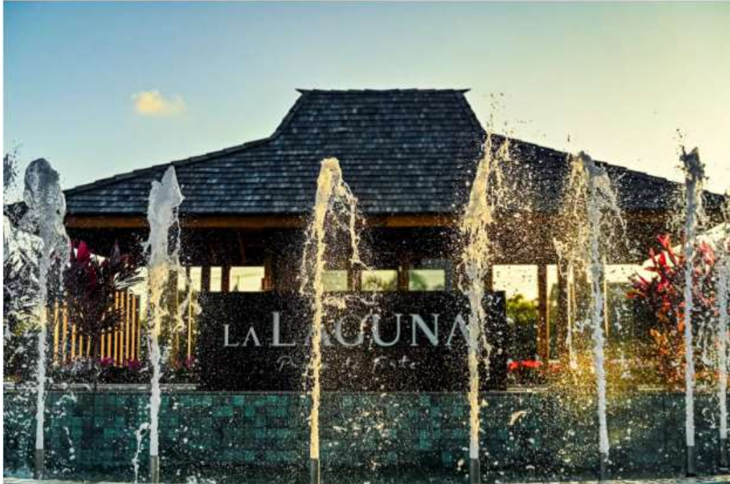
Figura 12 – Condomínio La Laguna Praia do Forte
