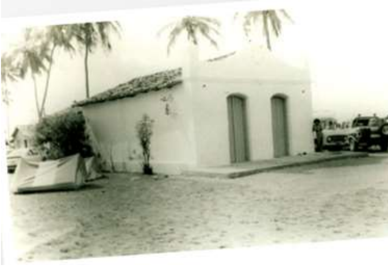
Figura 4 – Igreja de São Francisco antes e depois da reforma e seu entorno (prainha).
