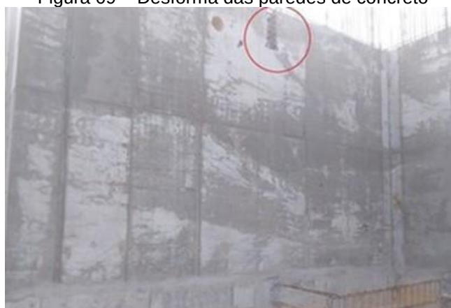
Figura 09 – Desforma das paredes de concreto
