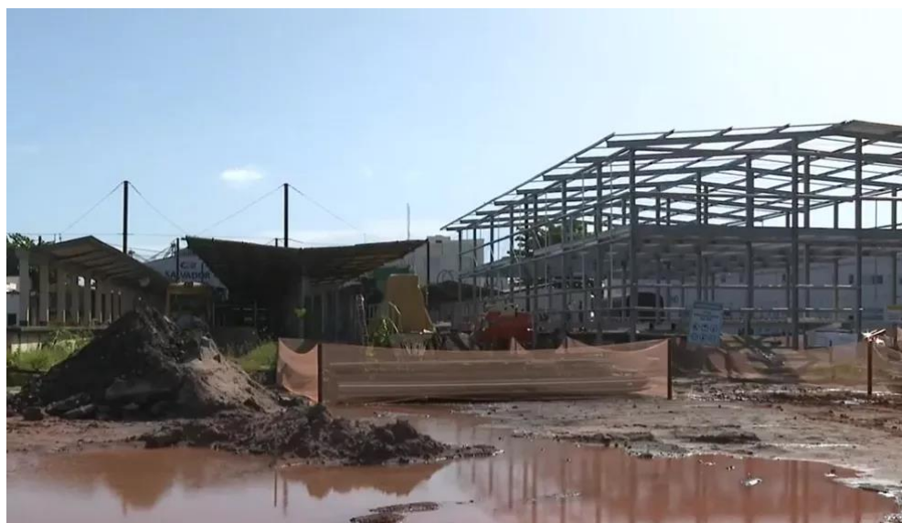
Figura 5: Fotografia das obras em andamento.
