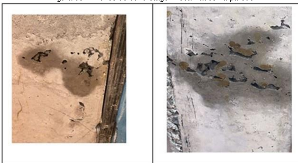
Figura 05 – Nichos de concretagem localizados na parede
