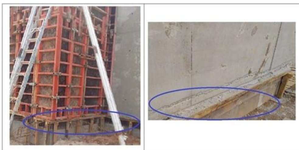
Figura 08 – Montagem auxiliar dos painéis
